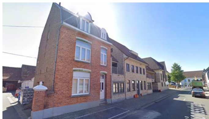
Stationsstraat, 2022 © Google maps
