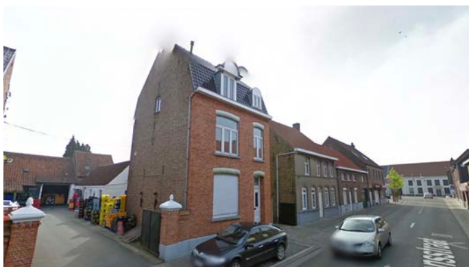
Stationsstraat, 2009 © Google maps
